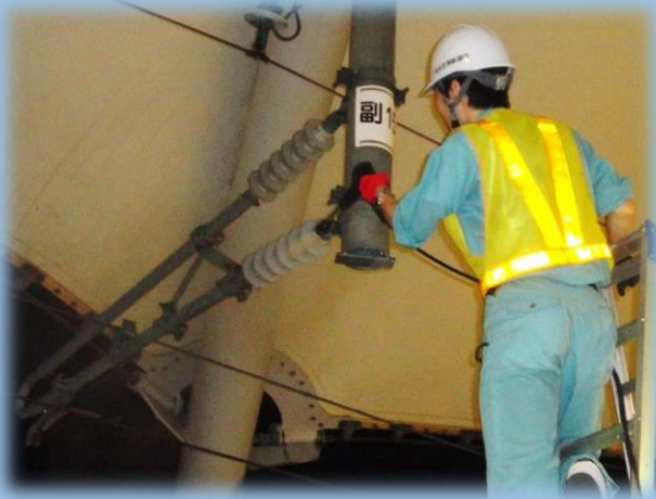
電車線の点検
