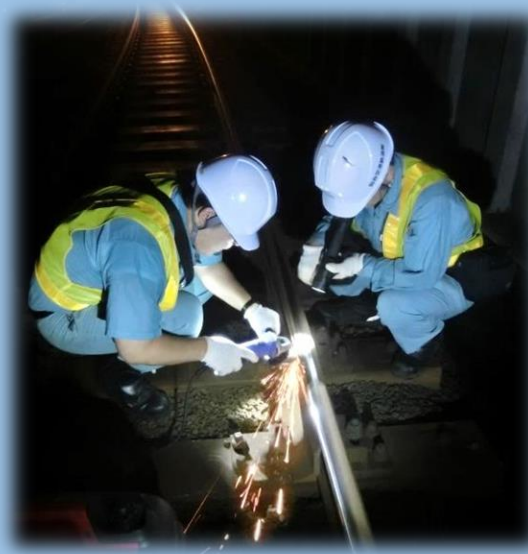
レールの修理
